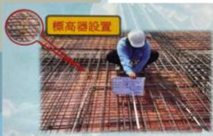
地坪確實設置標高器
