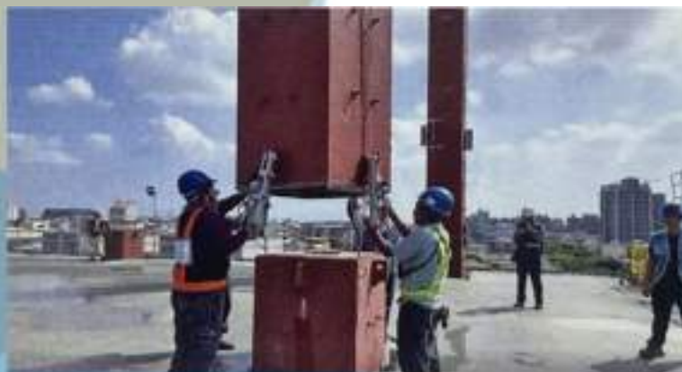
鋼構吊裝採用ACEUP工法，安全、快速及精準。
