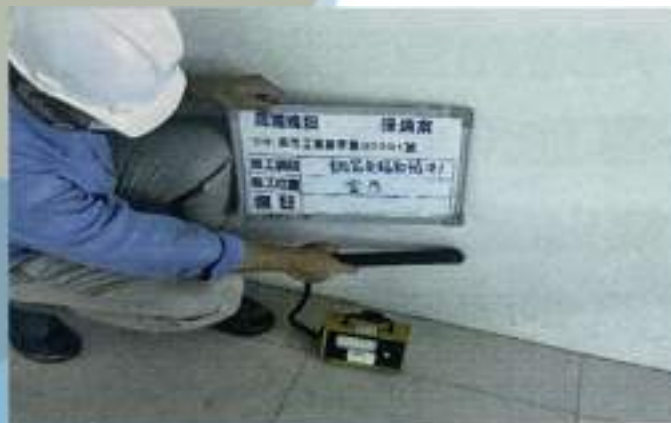
輻射檢測儀檢測，確保建築結構安全無虞
