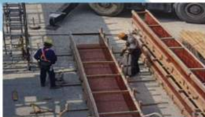
梁模於地面上預組，降低勞工高空作業風險
