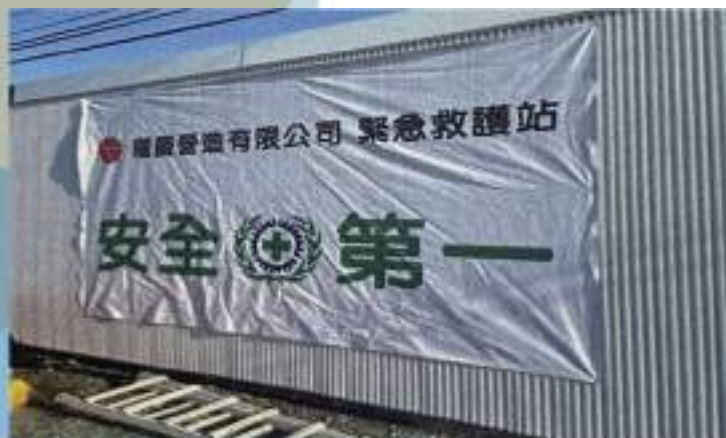
工區設置緊急救護站，關懷勞工
