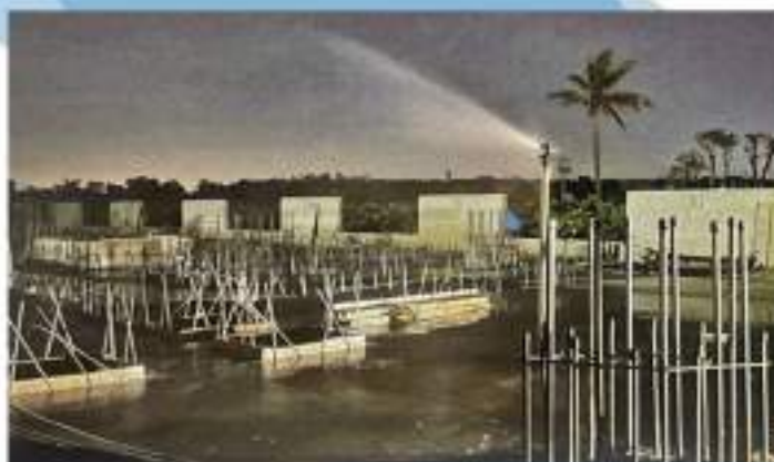
混凝土澆置後養護-地坪夜間噴水養護
